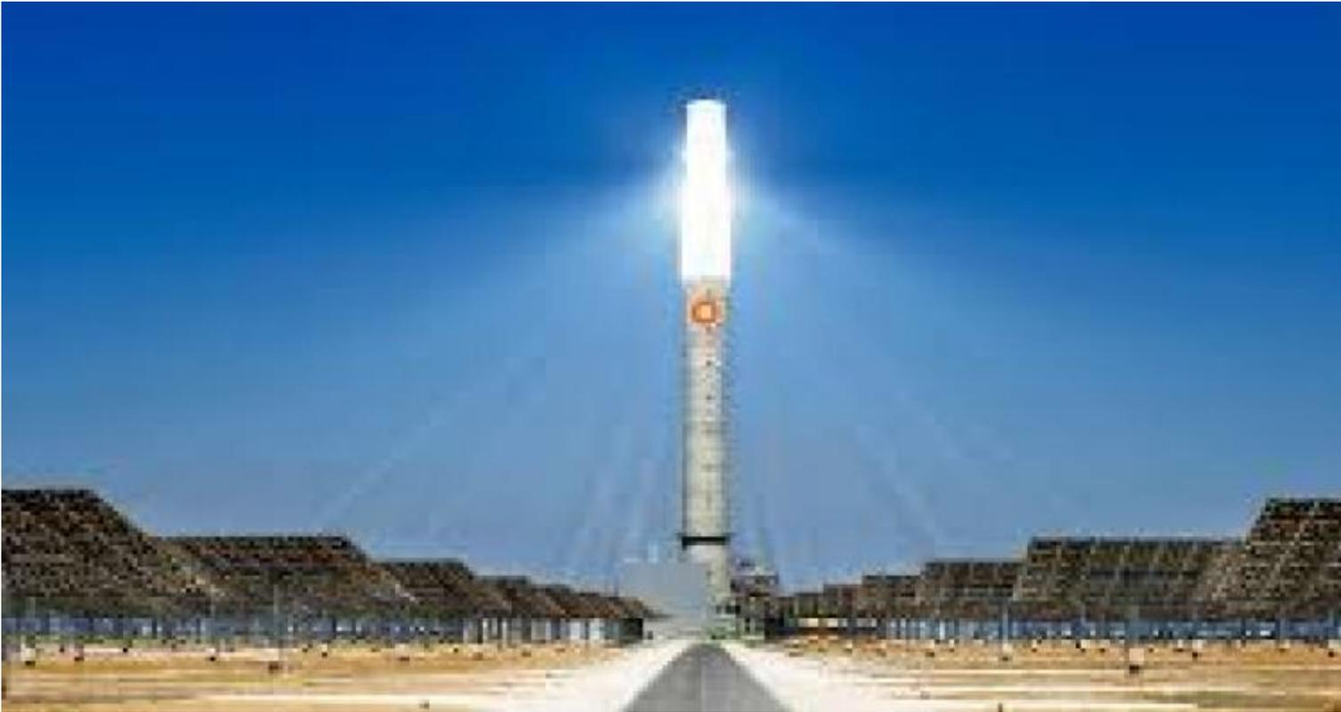
El uso de la energía solar térmica ha ganado espacios con la puesta en marcha de varias instalaciones, en las cuales un gran número de espejos móviles, llamados heliostatos, concentran los rayos solares hacia una torre central.
