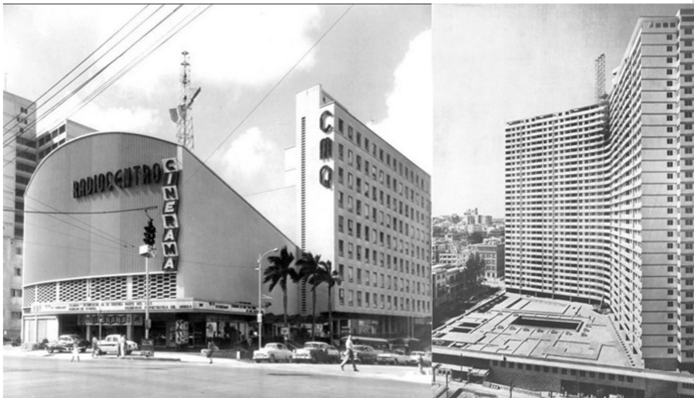
Edificios Radiocentro y Focsa
