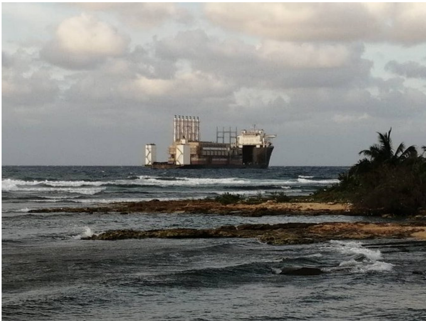
Nueva central flotante para la generación eléctrica en Cuba
