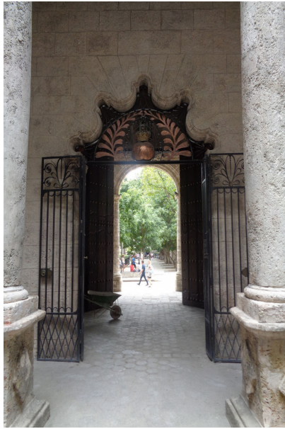
Palacio del Segundo Cabo
