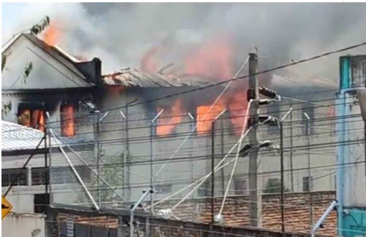
Centro de Adolescentes Infractores Virgilio Guerrero, en Quito.
