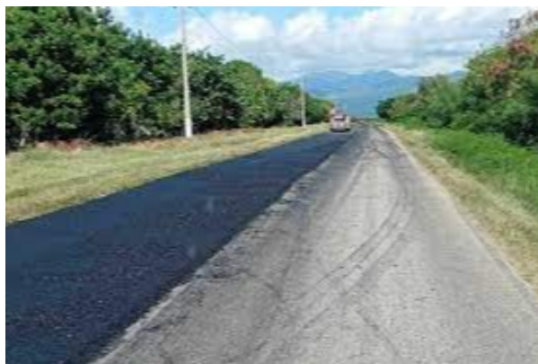
Pavimentación del pedraplén
