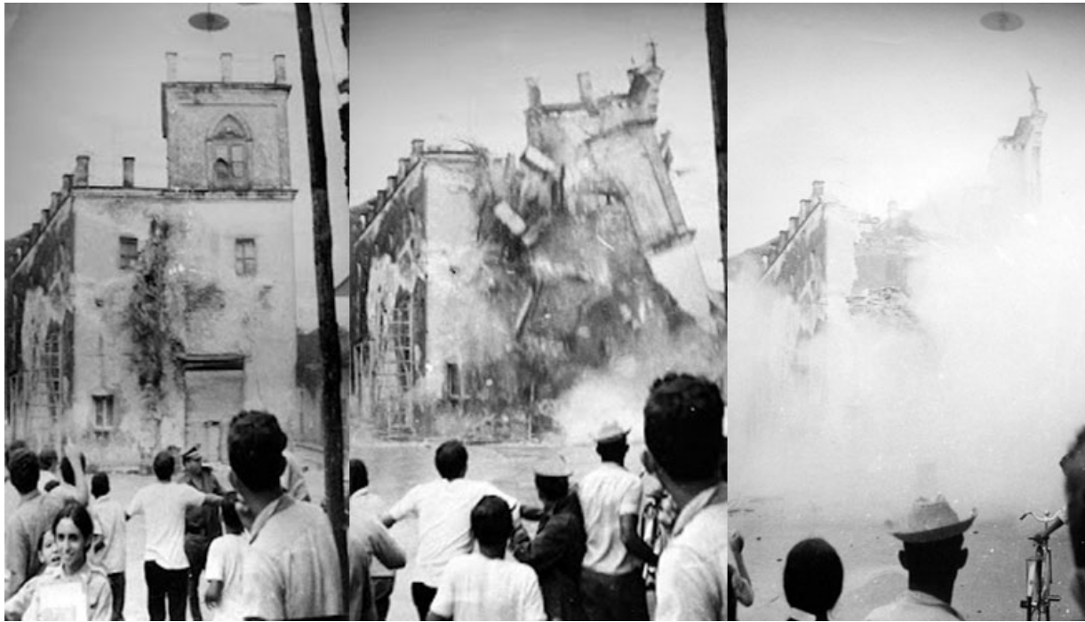
Derrumbe de la ermita
